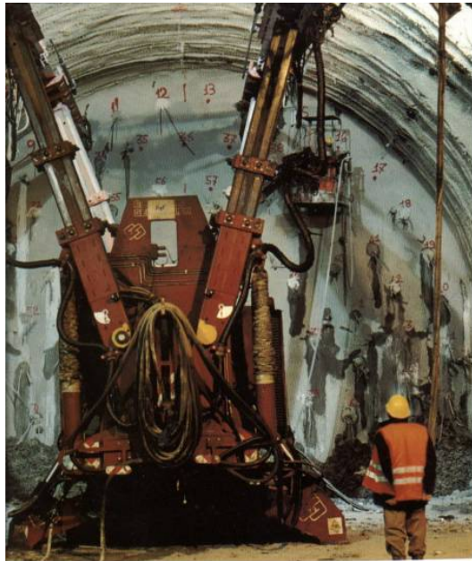
Fig.1 Preconsolidamenti del fronte (posizionatore)
